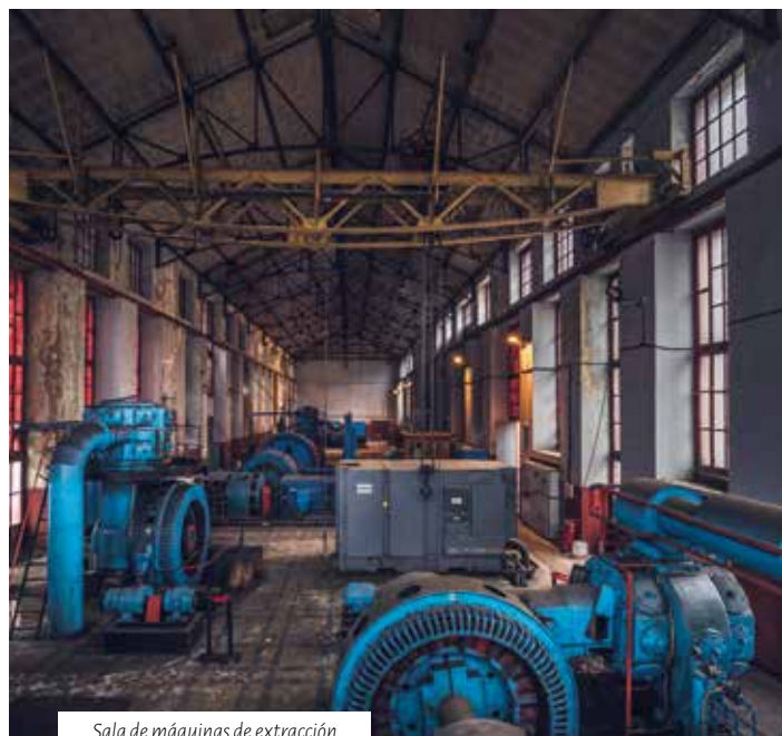
Sala de máquinas de extracción
