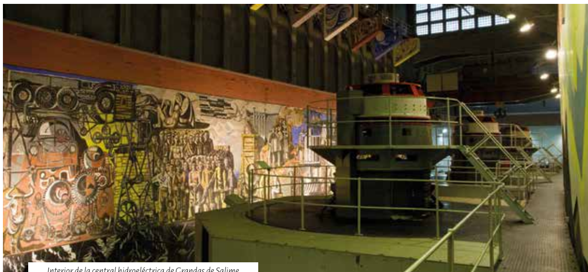
Interior de la central hidroeléctrica de Grandas de Salime
